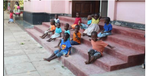
Nieuwe traptreden, oude waren erg beschadigd..
